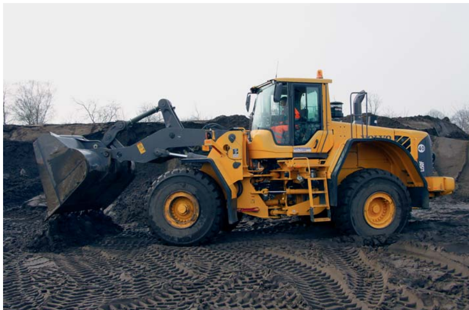
Mit diesem Radlader wird Erde bewegt.
