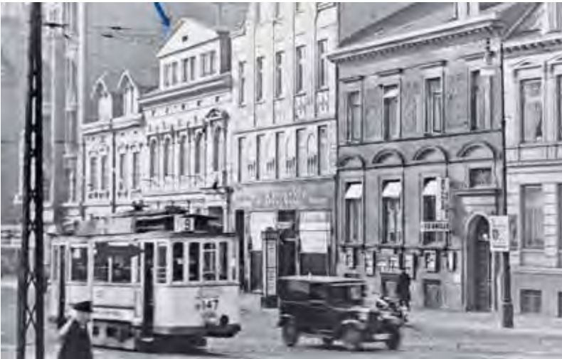
Das historische Gebäude (siehe Pfeil) der Industrie und Handelskammer zu Kiel am Schlossgarten
